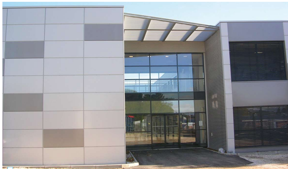
Le bâtiment de Parasitologie, un des derniers «achats» du CHRU
