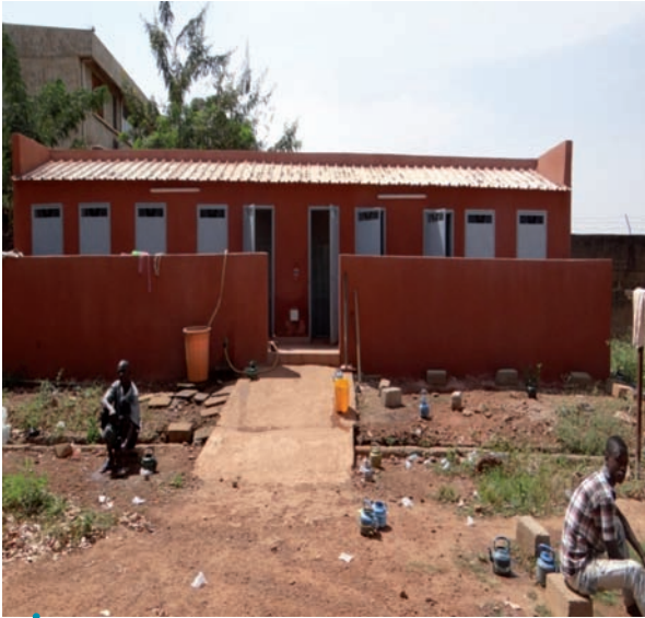
○ Latrines du CHU Yalgado Ouedraogo, ○ Ouagadougou, Burkina Faso
