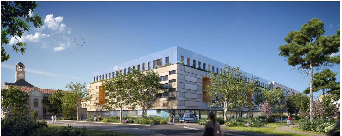
©Séquences, MDR Architectes et Archi Graphi - Perspective depuis l'entrée du CHU Montpellier
